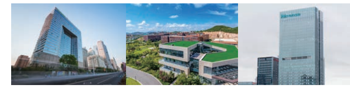
青島 ハイセンス本社ビル 青島 R&Dセンター 深圳 ハイセンスビル
