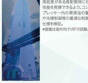
高低差がある長配管時にも性能を発揮できるよう、コンプレッサー内の潤滑油の量や冷媒制御等の最適な制御仕様を検証。 *画像は海外向けVRFの試験。
