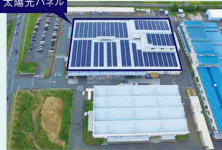
浜松事業所にて屋上に太陽光パネル設置
